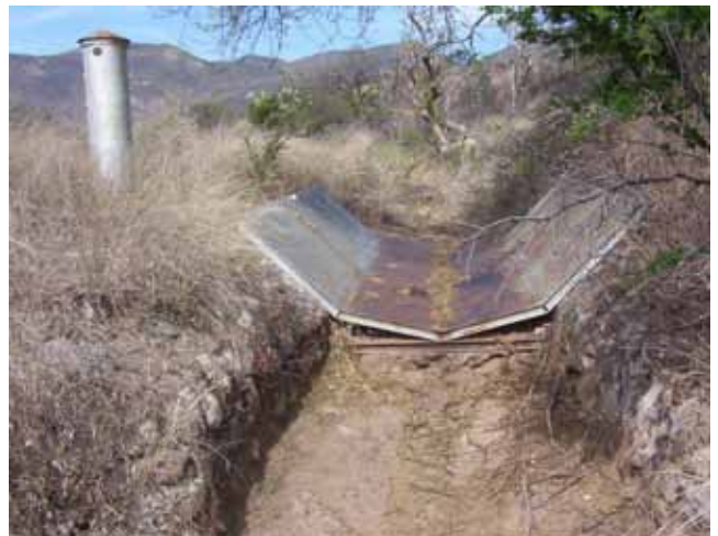
FIGURA 2. Estación de aforo con vertedor para flujo supercrítico tipo Santa Rita y limnógrafo FUESS en la cuenca La Cruz, Tabasco, Zacatecas.
