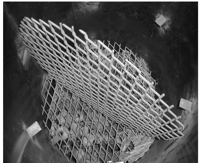
Figura 5. Colocación del soporte dentro Biodigestor.
