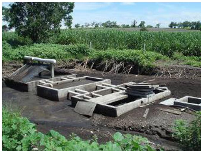
Figura 1. Sistema de tratamiento de excretas porcinas por medio de cribado, separación de sólidos y sedimentación
