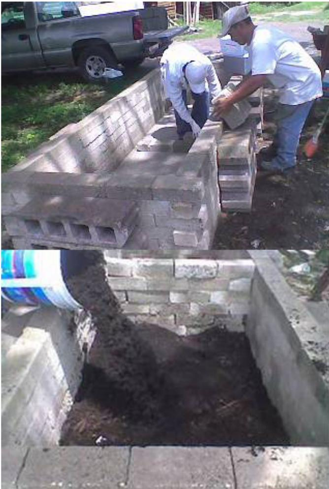
**Figura 2.- Construcción y alimentación del vermicomposteo**
