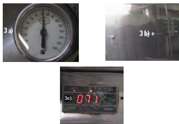
Figura 3. Sistema de control de temperatura: a) Termómetro bimetalico, b) Termopares, c) Indicador de temperatura.
