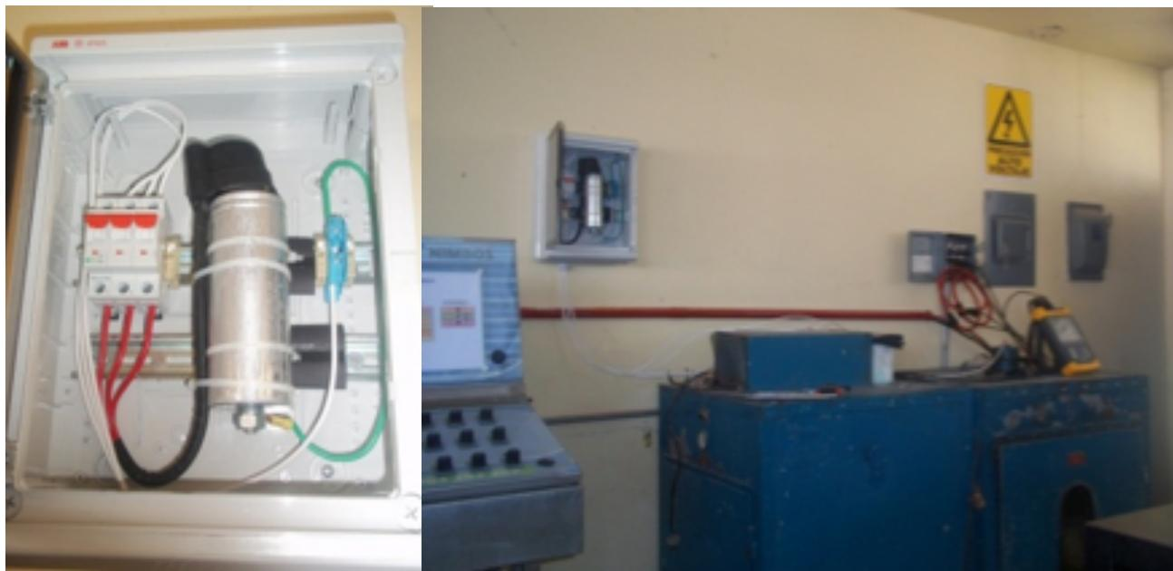
**FIGURA 9.** Banco de capacitor conectado a sistema de riego.
