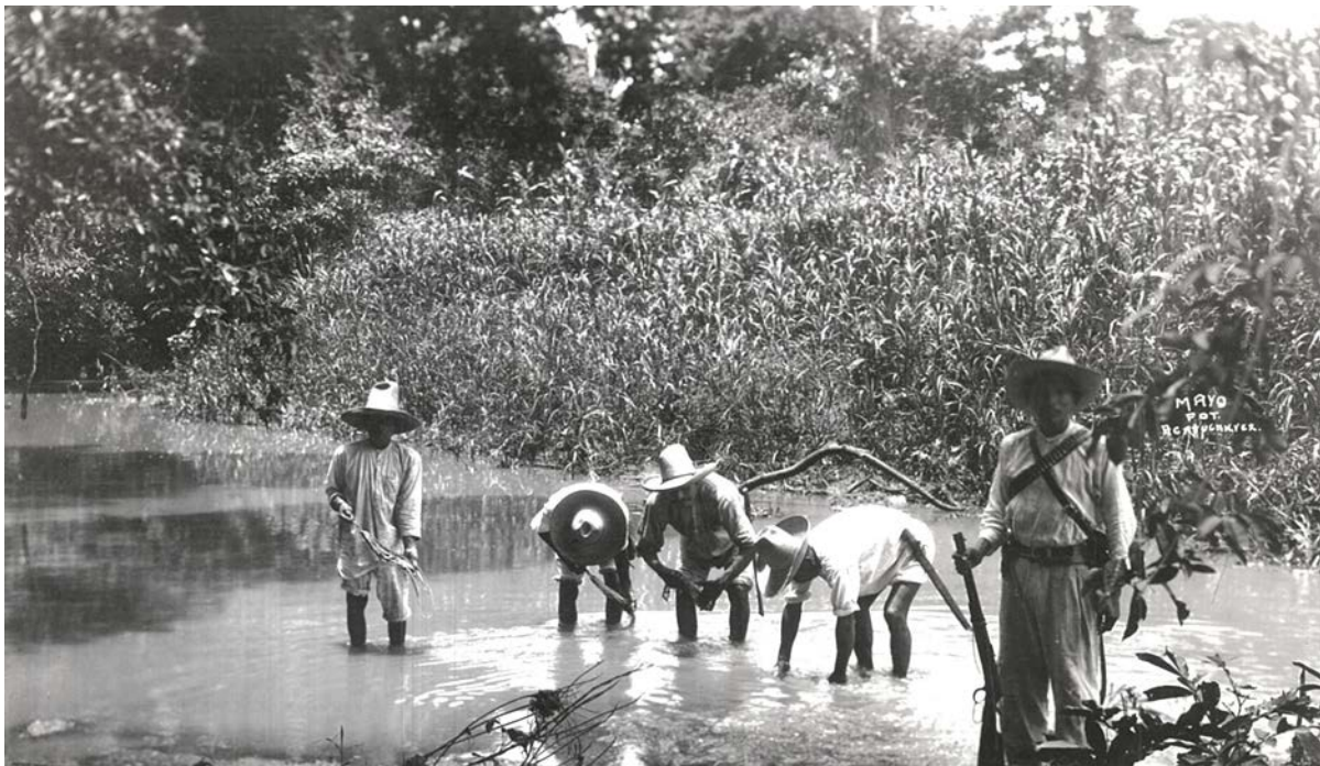
Fot. No. 18. Operación del lavado de la fibra "pita de Oaxaca". La fibra una vez lavada, la ponen á secar en tendedores de palos en forma de caballete que colocan fuera de las casas, á fin de que se seque y blanquee, quedando lista para la venta (Fot. No. 19).
