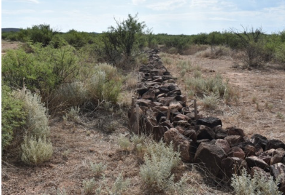
Figura 3. Otras obras de conservación de suelos y agua en la Reserva. A) Bordos de piedra acomodada y B) Micro-cuencas en área de distribución de la tortuga del bolsón.
